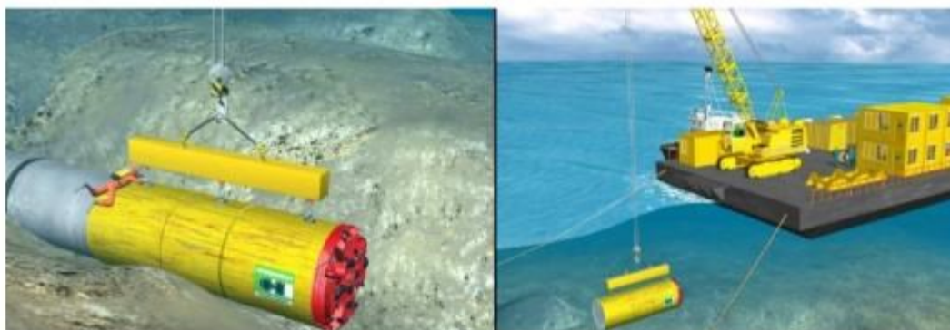
Figura 11.3: Recupero della fresa meccanica a mare
